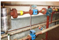
Теплопункт, смонтированный ООО НПФ «Энергоконтроль», г. Иркутск
